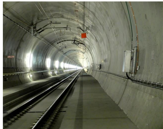
Tunnelröhre des Gotthard-Basistunnels (GBT)
