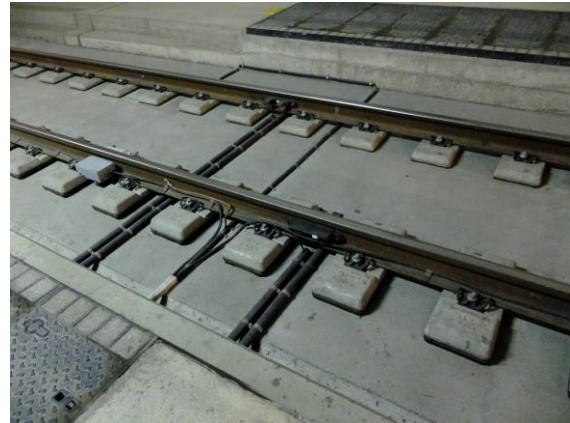
Feste Fahrbahn im Gotthard-Basistunnel (GBT)
